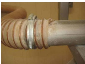
Flexibele koppeling niet geaard
